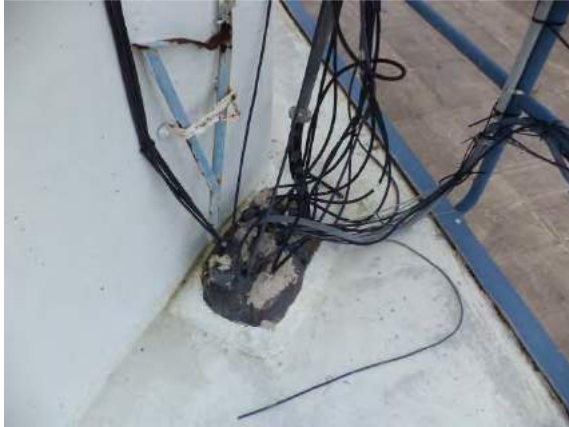
Conduit penetration
